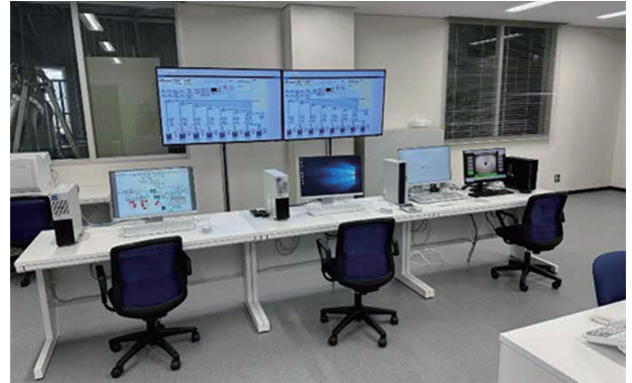
写真－5 SCADA（中央監視装置）
