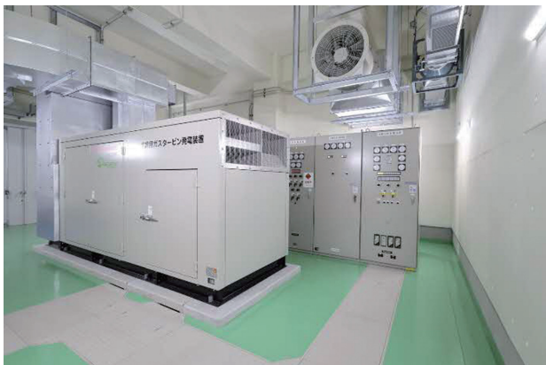
写真－4 非常用ガスタービン発電装置
