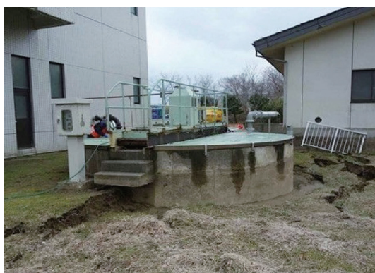
写真－2 浮上した重力濃縮槽 (羽咋浄化センター)
