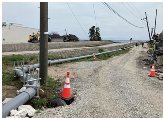
写真－3 仮設圧送管（珠洲市）
