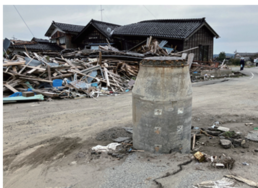
写真－1 倒壊家屋と人孔浮上 (珠洲市宝立地区)
