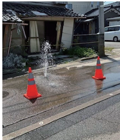
写真ー2 上水管路被災写真（2）
