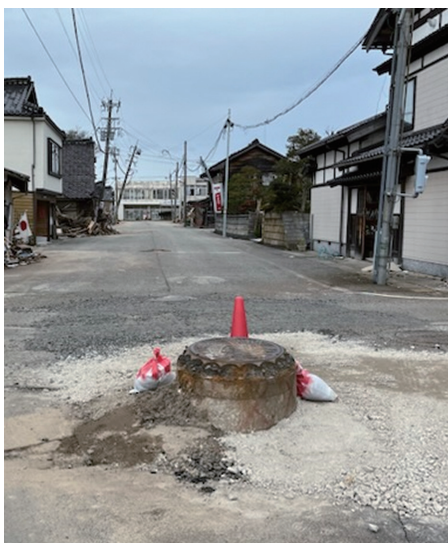
写真－3 下水管路被災写真（MH）
