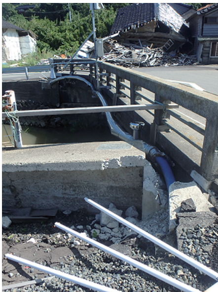
写真ー1 上水管路被災写真（1）
