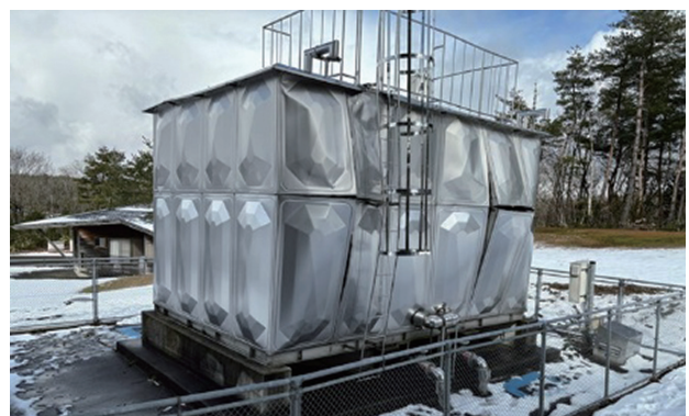
写真－４ ステンレス配水池の被害（能登町）
