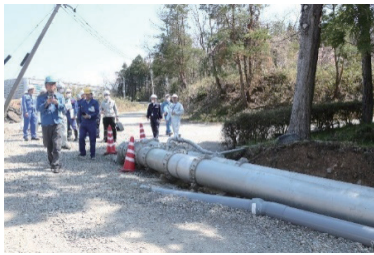
写真－１ 輪島市送水管仮配管
