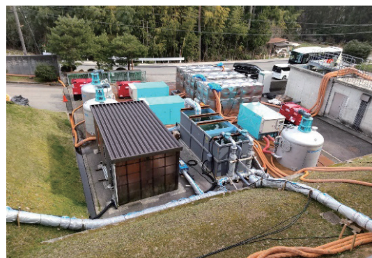
写真－2 珠洲市宝立浄水場の可搬型浄水装置
