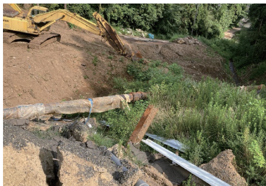
写真－1 能登町の耐震管路の離脱
