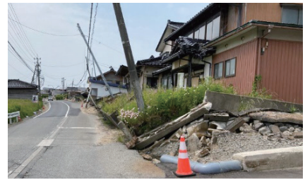
写真－３ 内灘町液状化に伴う被害状況
