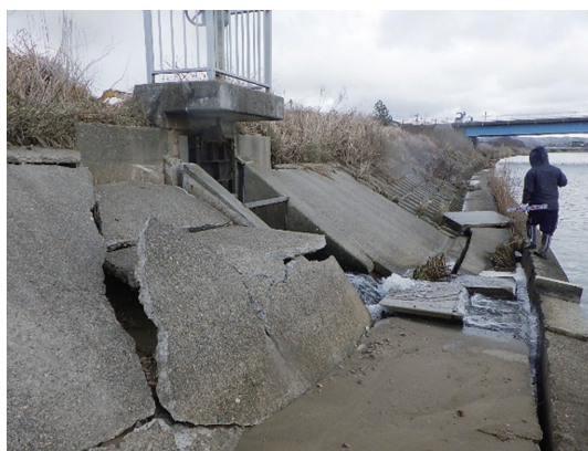
写真-3 吐口の被災状況
