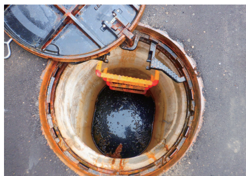
写真－1 管路施設の被災状況（左：マンホール浮上 右：管路たるみによる汚水滞留状況）
