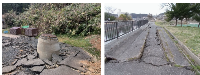
写真－1 穴水町下水道管路施設の被災状況
