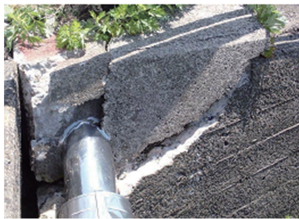
写真－３ 水管橋下部工等のひび割れ・破損
