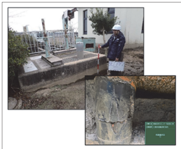
図－7 塩素混和池の傾斜及び杭頭の破損
