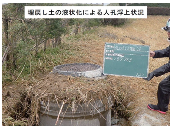
写真－３ 下水道管路の被害状況（人孔浮上）
