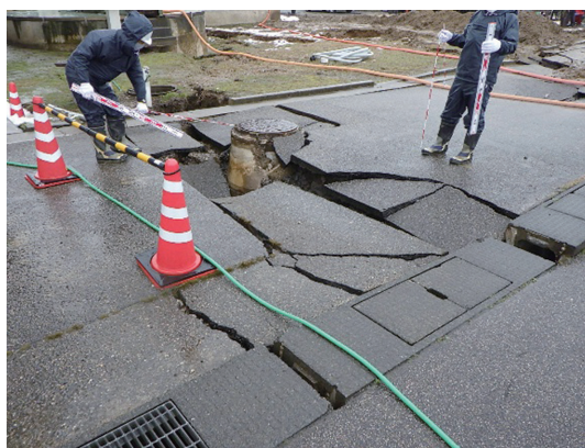
写真-6 場内道路の陥没状況
