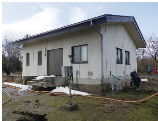
写真-4 塩素混和池棟の不同沈下
