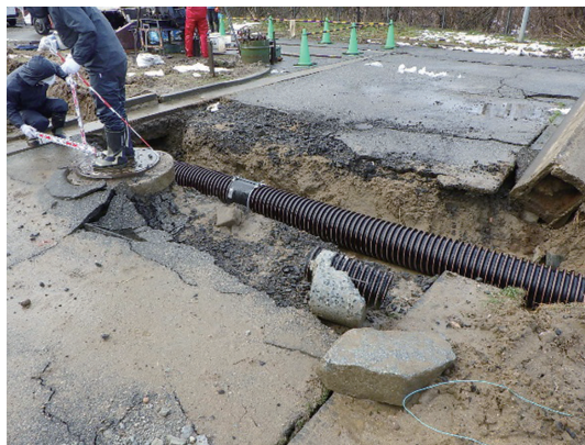
写真-2 仮設配管による応急復旧
