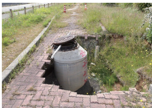
写真－1 管路施設の被災状況（左：マンホール浮上 右：管路たるみによる汚水滞留状況）
