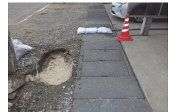
写真-7 漏水箇所 (新潟市水道局提供)
