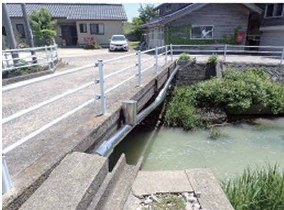
写真－２ 水管橋上部工主構部の変形・破損
