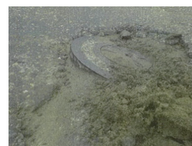
写真－4 弁蓋の被害
