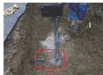
写真－10 VP継手の破損 (新潟市水道局提供)
