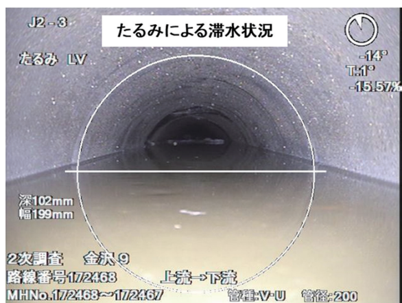
写真－１ 下水道管路の被害状況（たるみによる滞水）
