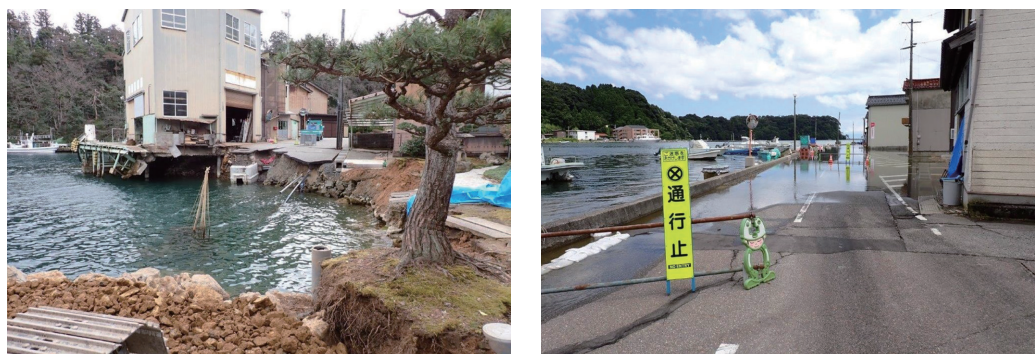
写真－２ 道路状況（左：地盤崩落箇所 右：海水による道路冠水箇所）
