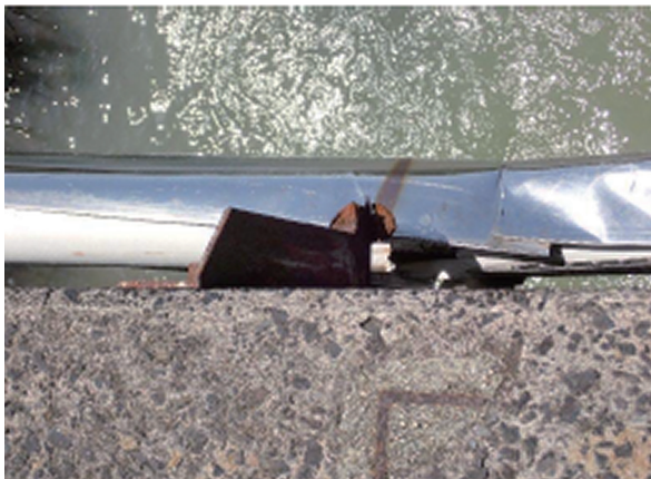
写真－４ 水管橋添架支持金具の破損
