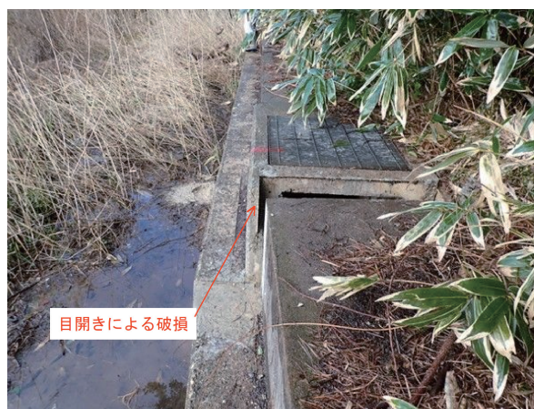
図-6 ボックスカルバート縦締め緊結の破損
