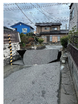
写真－2 路面の変状
