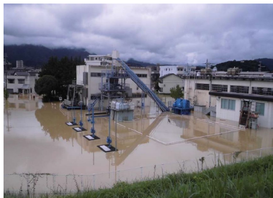
写真-2 ポンプ場の浸水状況
