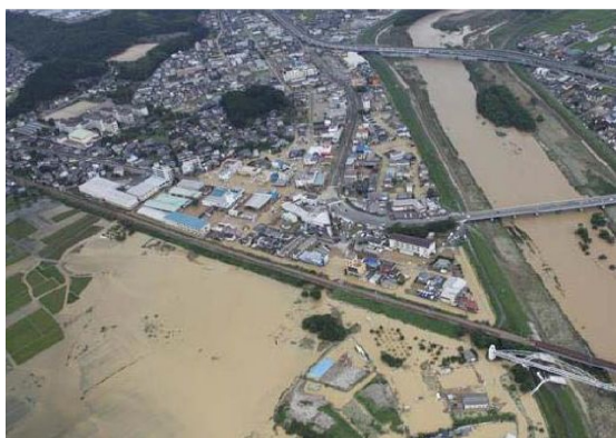
写真-1 市内の浸水状況
