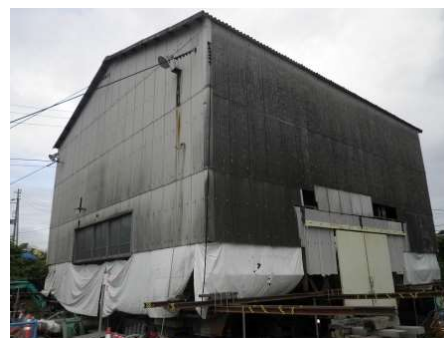
図-11 根がらみ工法を用いた工事事例
