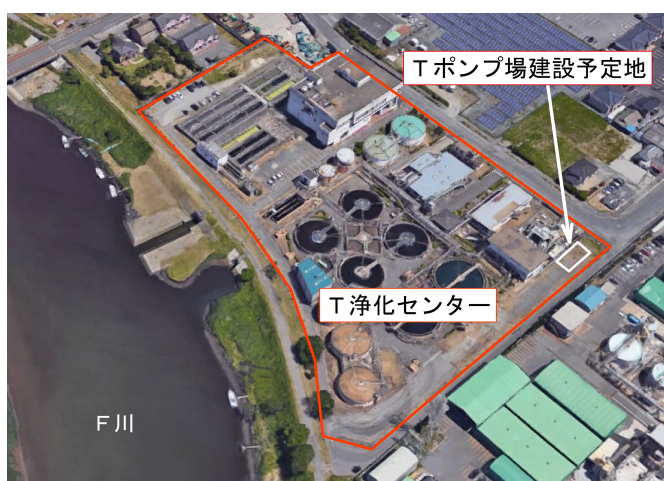
図-1 T 浄化センター及び T ポンプ場
