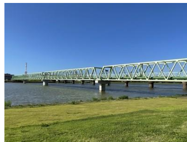
写真-1 水管橋全景
