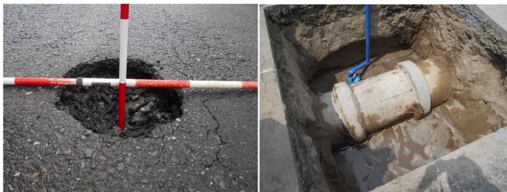
写真 2 陥没の写真
