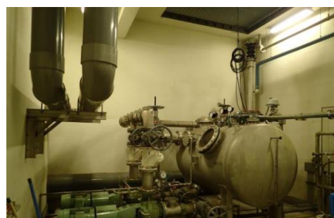
写真 - 1 真空式汚水収集装置
