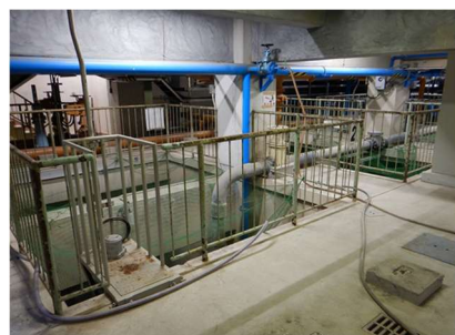
図 5 複雑な現場状況
