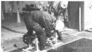
漏水修繕を体験
