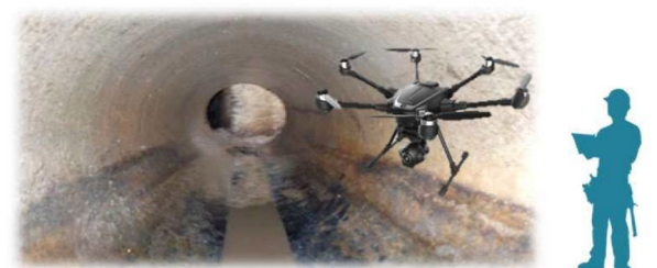
図2 ドローンによる管路点検イメージ (出典：国土交通省)
