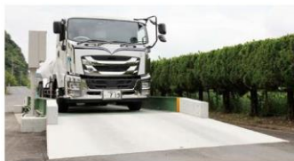
トラックスケール
